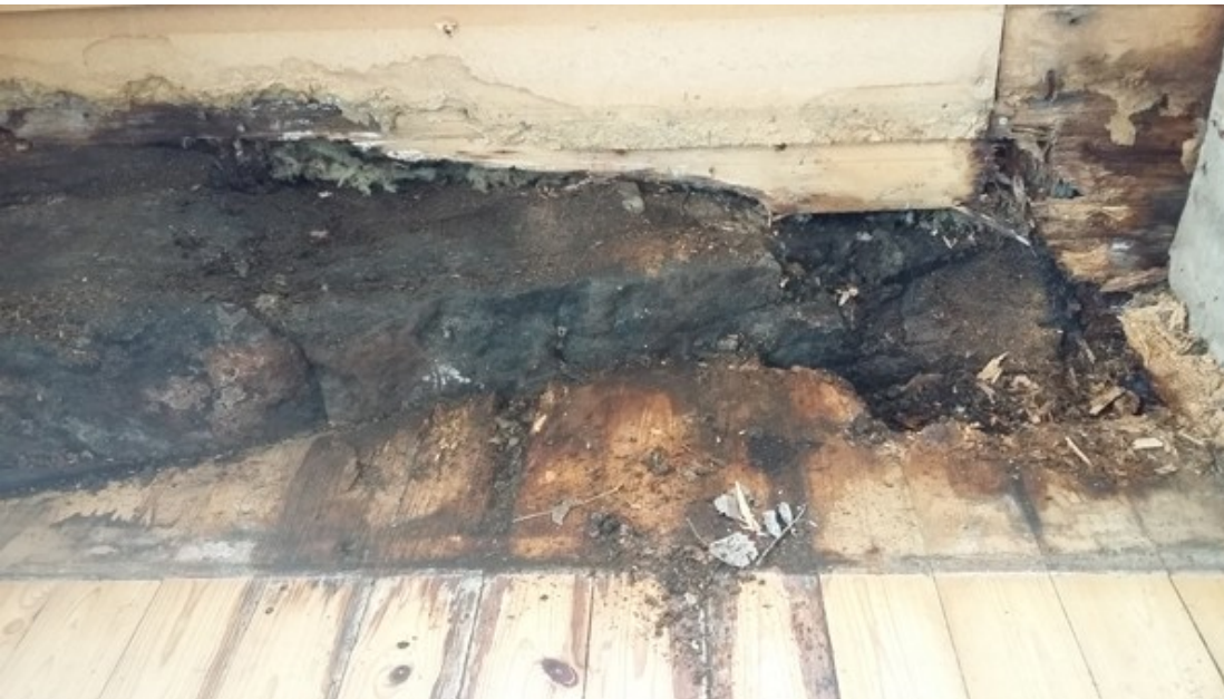
Under blindbotten och isolering finns berg i dagen.
